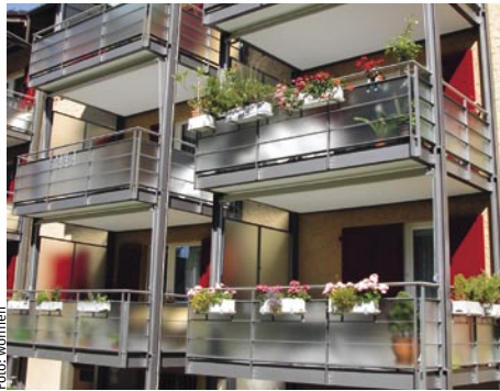
Die Betonböden sind mit Stahlwinkeln eingekleidet und bilden mit den Stützen eine Einheit.
